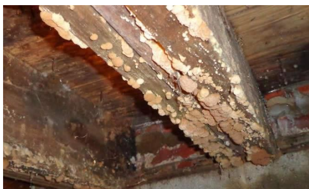
Zwamvorming op houten balken (afbeelding: vochtbestrijding-experts.nl)
