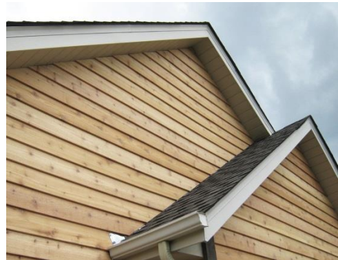
Dakoversteek beschermt de houten beplanking (afbeelding: Thermowood.be)
