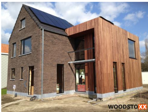
Hardstenen sokkel tegen opspattend vocht (afbeelding: woodstoxx.be)
