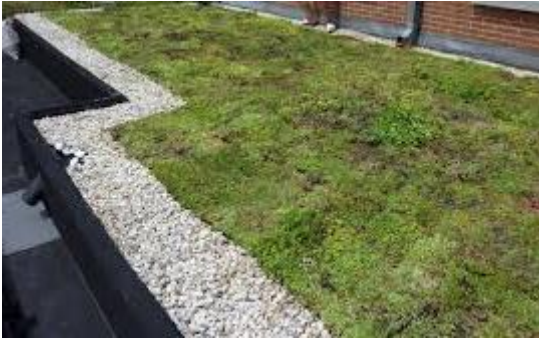
Grindstroken aan de rand van groendak + lage dakrandopstand (afbeelding:
