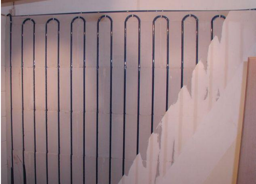
Muurverwarming bij blokken met ingewerkte sleuven
