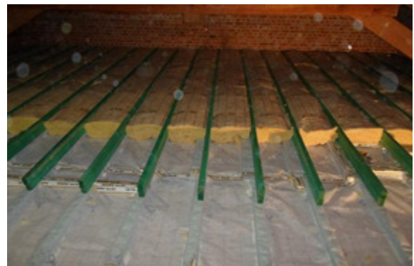
Luchtscherm, houten roostering en glaswolisolatie op de zoldervloer (foto: Isolteam)
