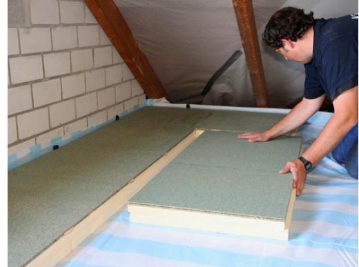
Drukvaste PIR-isolatieplaten met tand-en-groef en geïntegreerde spaanplaat (foto: Kingspan)
