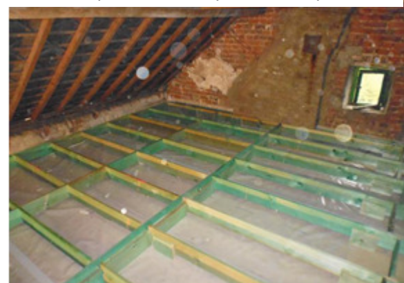
Plaatsen van een houten roostering op het luchtscherm, voor het aanbrengen van papiervloekenisolatie (foto: Isolteam)
