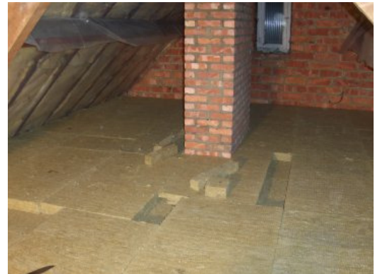
Drukvaste rotswolisolatie in twee lagen (foto: Isolatie Verhoeven)
