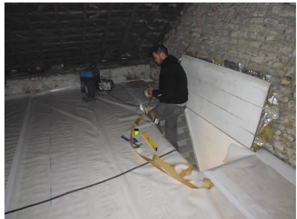
Plaatsen van een luchtschermband (PE-folie) op de bestaande zoldervloer (foto: Isolteam)
