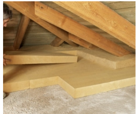
Drukvaste houtvezelisolatieplaten in twee lagen, met verspringende voegen (foto: Steico)
