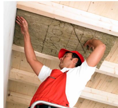
Zoldervloerisolatie via de onderzijde met rotswol (Foto: Rockwool)
