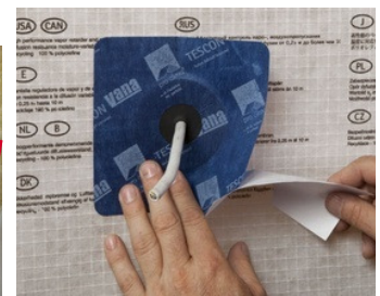
Leidingdoorvoeren afwerken met lichtdichtingsmanchet (foto: ProClima)
