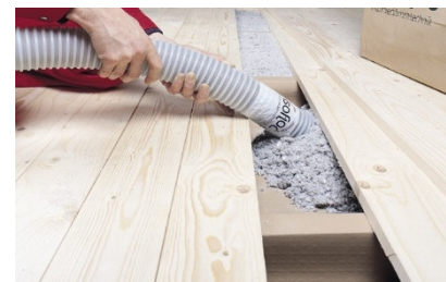
Papiervlokken inblazen (foto: IsoProc)
