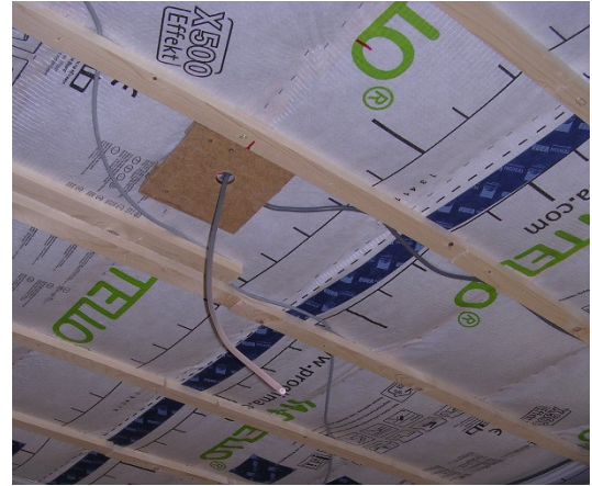
Luchtschermband bevestigen en afkleven, latten en kabels plaatsen tussen de latten (foto: E. Willaert)
