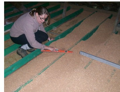
Zoldervloer isoleren met kurkkorrels (Foto: Recycork)
