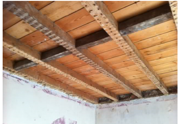
Zoldervloer zonder afwerking aan de onderzijde: geschikt voor isolatie tussen de draagstructuur (foto: Bouwinfo)
