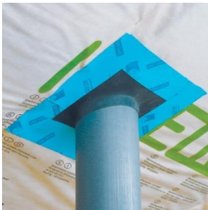
Dakdoorvoer met luchtdichte afwerking (Foto: ProClima)
