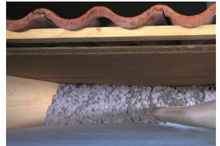
Isolatiemateriaal inblazen (foto: Isoproc)
