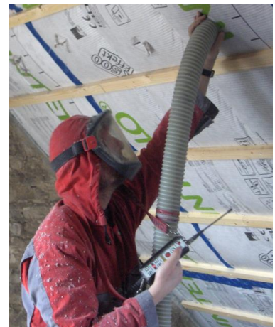
Isolatiemateriaal inblazen (foto: arch. J. Van den Broeke)
