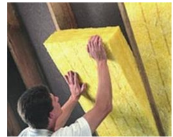
Spantendak isoleren (foto: Isover)
