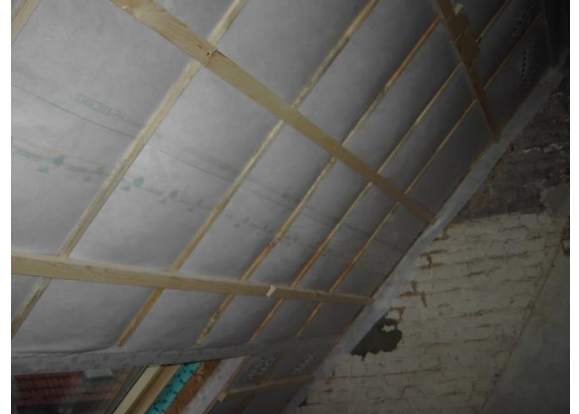
Luchtdicht afgewerkt hellend dak (Foto: E-advies)
