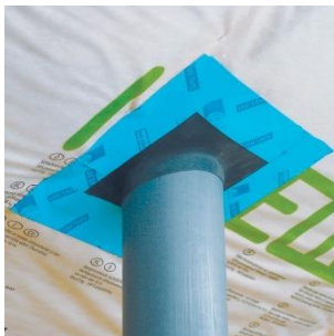
Dakdoorvoer met luchtdichte afwerking (Foto: ProClima)
