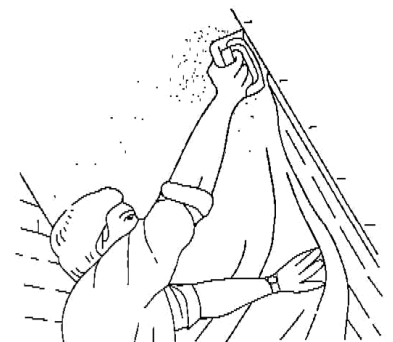
Luchtdicht afgewerkt hellend dak (Foto: E-advies)
