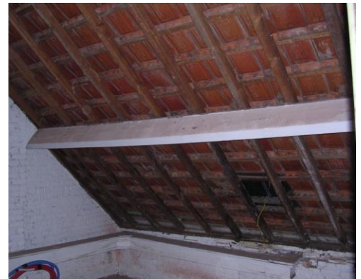
Hellend dak zonder onderdak (Foto: E. Willaert)
