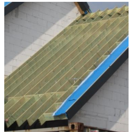
Dak met hoge kepers (Foto: arch. D. Van)
