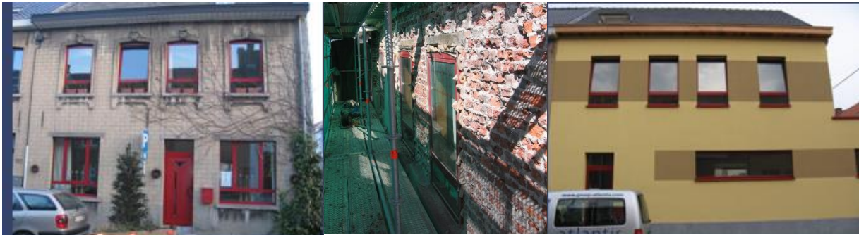
Woning Halle: afbraak gevelmetselwerk, buitenisolatie met gevelpleister. Foto's voor, tijdens en na de werken.
