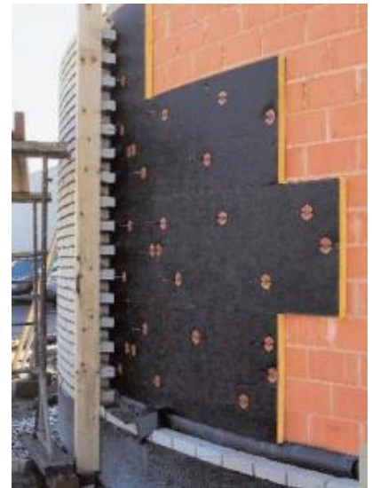
Gebogen wand met glaswolisolatie (foto: www.baksteen.be )
