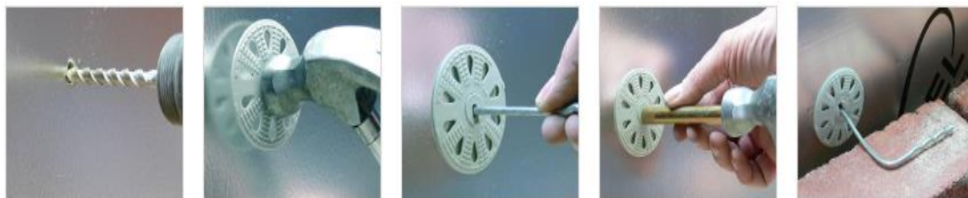
Spouwankers met plug (foto's: www. Massiefpassief.be)
