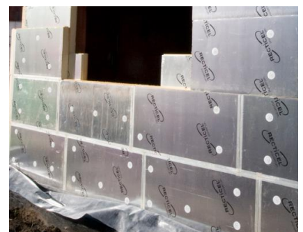
Polyurethaanisolatieplaten met afgekleefde voegen (foto: Recticel)
